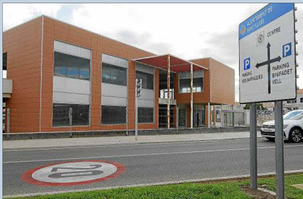
El edificio, concebido como centro comercial, nunca llegó a abrir sus puertas.
