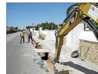
Las obras toman la Carretera Nova.
