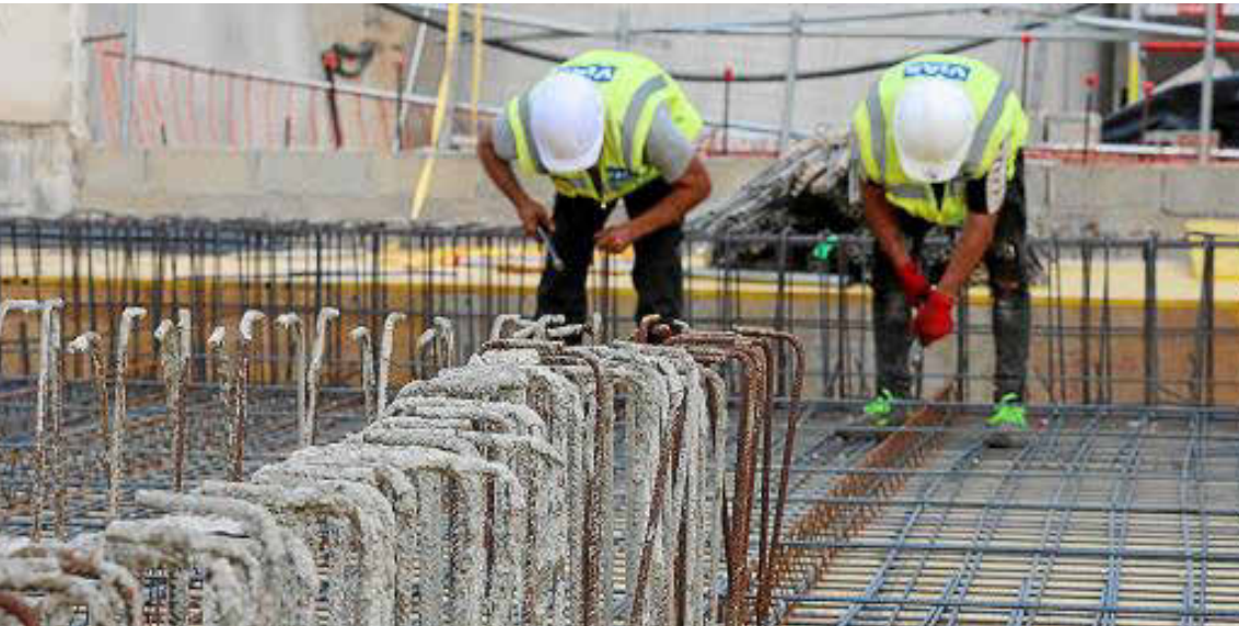
Imagen de unos obreros ejecutando un proyecto de obra mayor. Foto: GEMMA ANDREU
