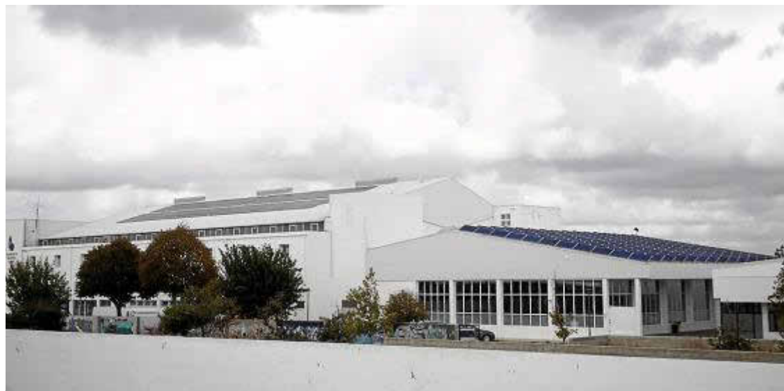
Placas. Ecosis ha ejecutado la ampliación de la instalación fotovoltaica sobre la cubierta del polideportivo municipal de Maó, con 98 kwp de paneles fotovoltaicos y 165 kwh de baterías. Foto: M. SERVERA
